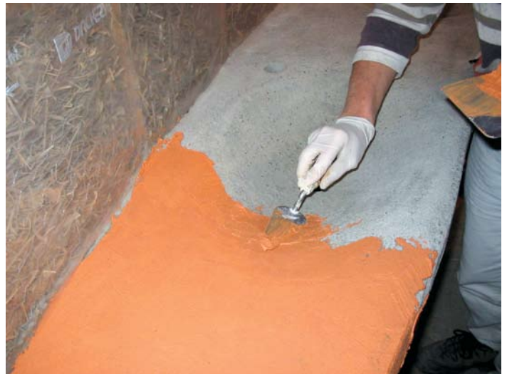
La pose du tadelakt sur les vasques fut effectuée avec une truelle de finition surnommée « langue de chat », qui permet de mieux travailler les formes arrondies et les détails.
