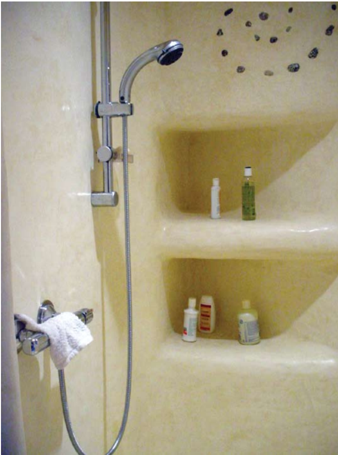
La douche en tadelakt est fonctionnelle ! Remarquer les insertions de galets en haut des tablettes de shampooing et de savon.
