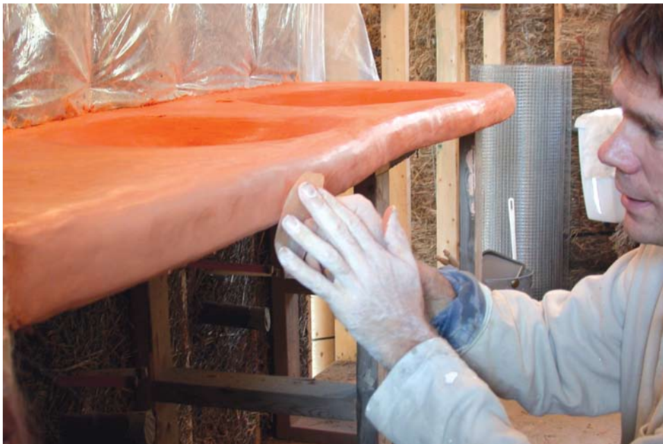
Le lissage au plastique permet les formes arrondies pour les vasques de salle de bains. Artisan : Bruno Thouvenin.
